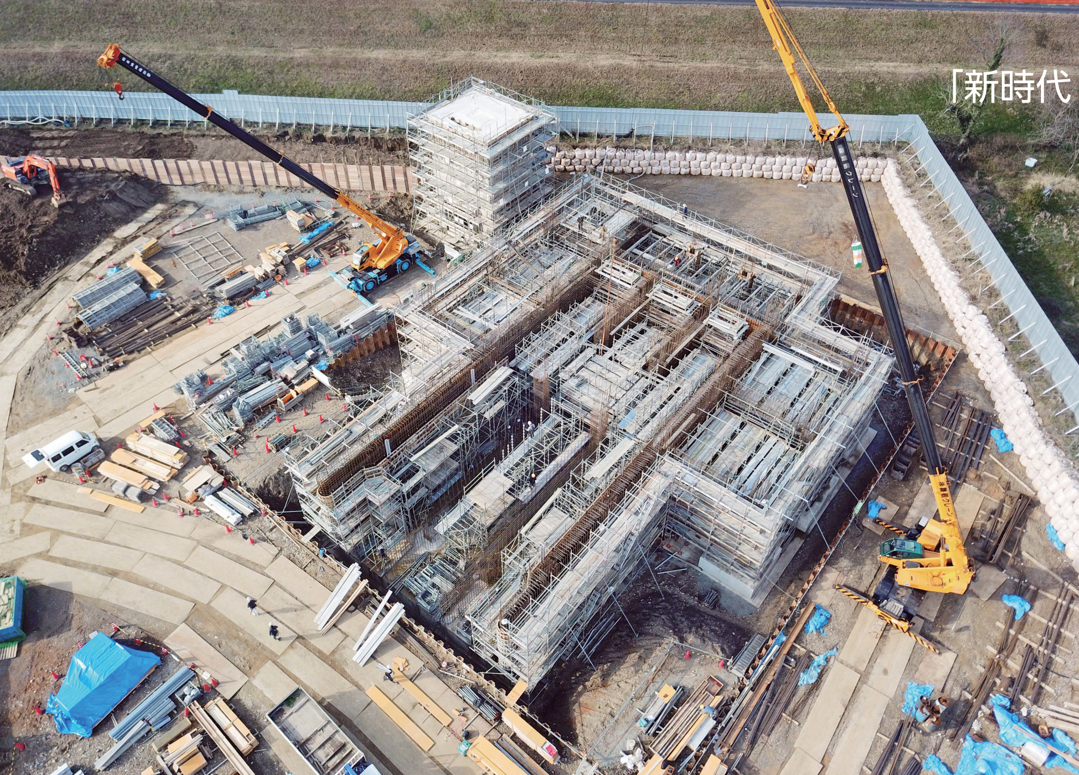
建設が進む段烟雨雨水ポンプ場。排水能力は7.2m 3 /秒を有します。今年度予算：約11.1億円
