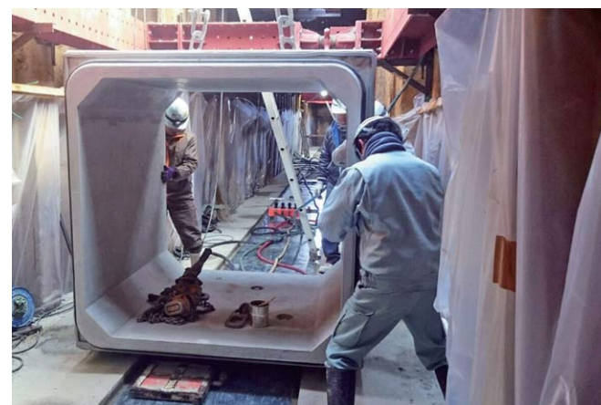
雨水排水路設置の様子。今年度は法川排水区で約5.6億円をかけて新設します。
